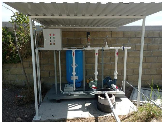
**Figura 22.** Sistema hidroneumático para eficiencia en el sistema de riego
