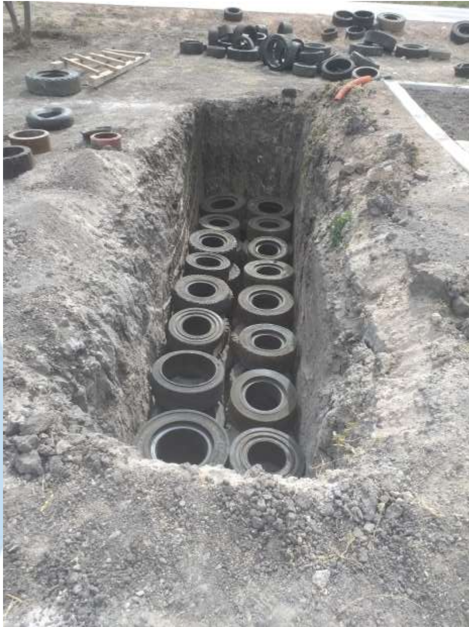
Imagen de la Berma de Infiltración
