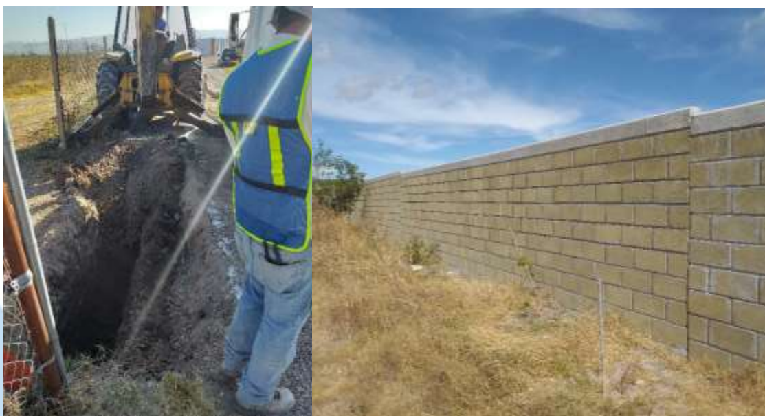
Obra en proceso
