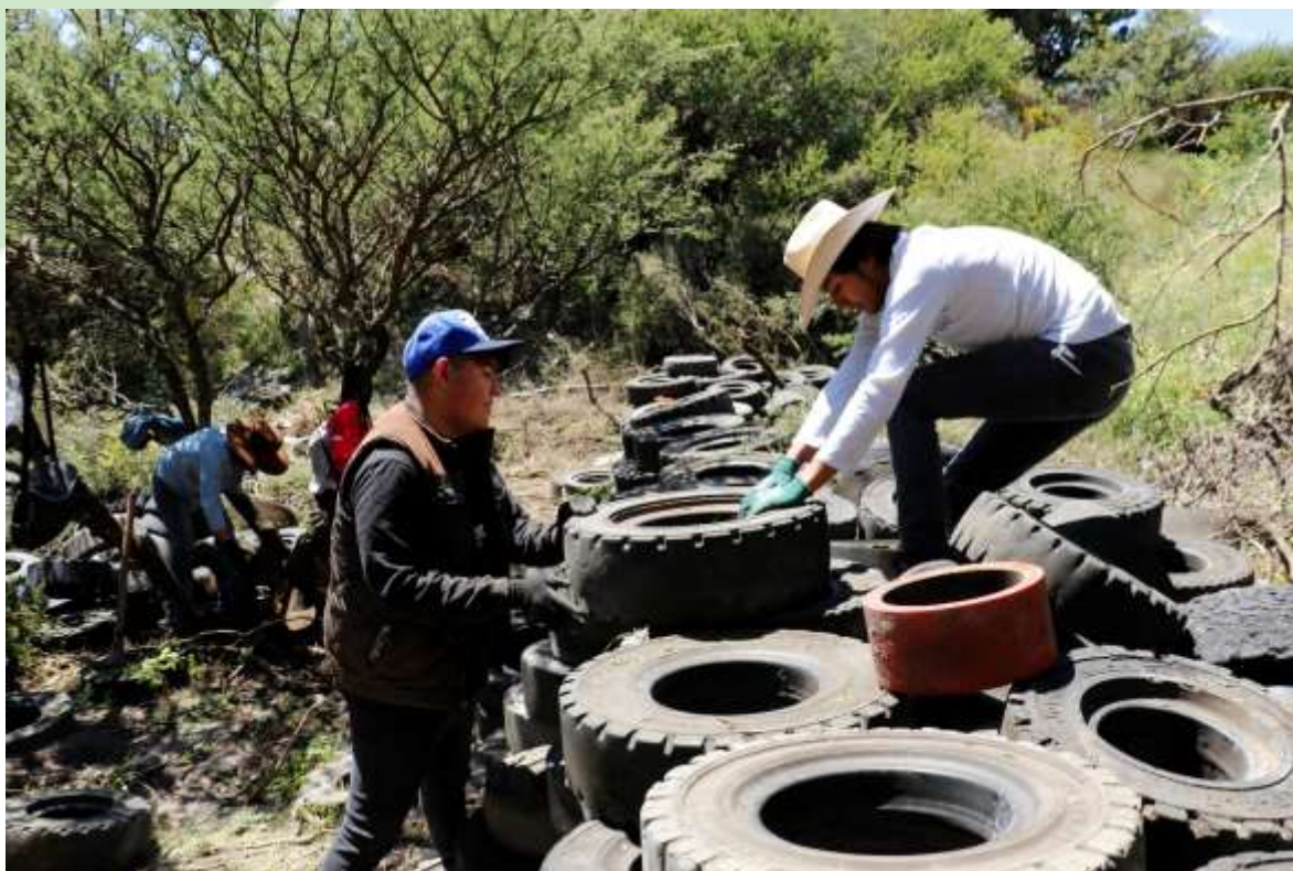
Fotografía: Obras de conservación de suelo y agua
