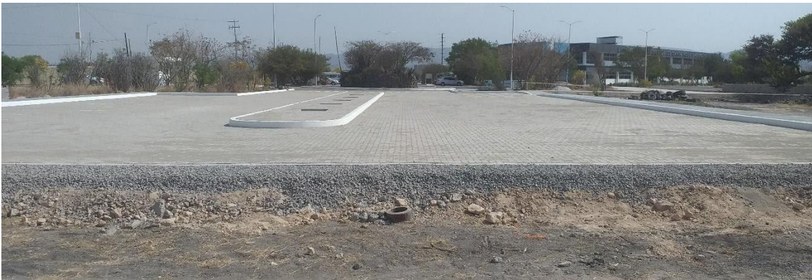
Imagen 5.2.5: Mantenimiento menor del estacionamiento
