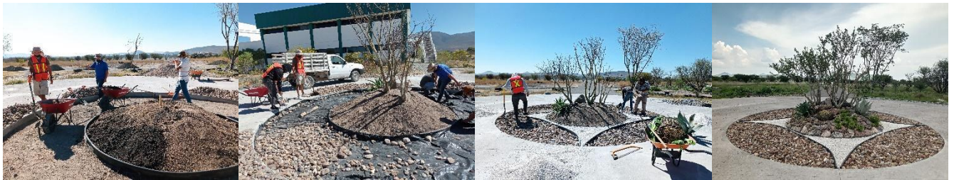
Imagen 6.1.7: Construcción de glorieta con especies de flora nativa
